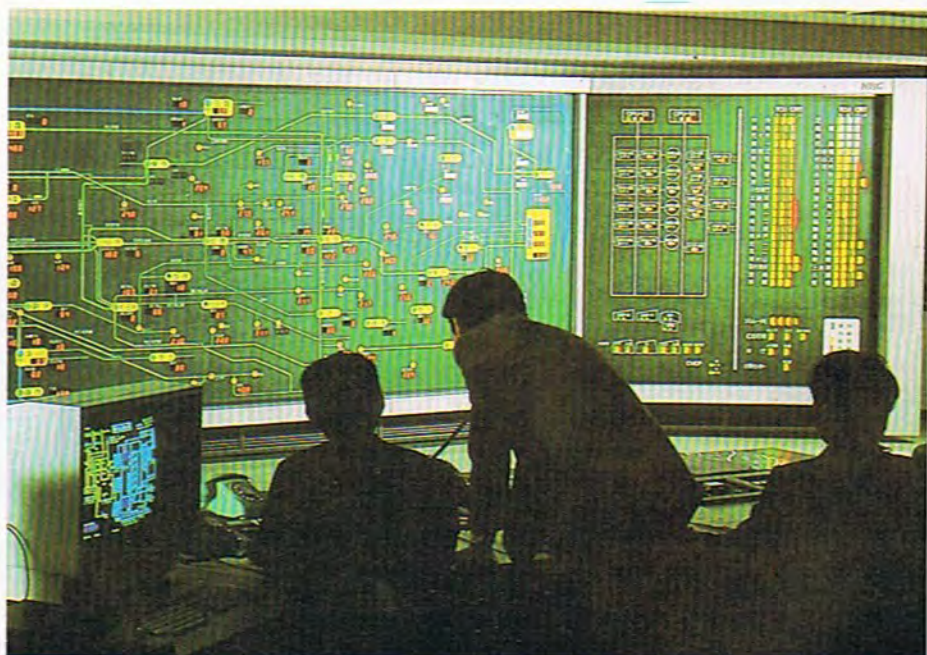
Una de las aplicaciones más espectaculares del teleproceso, combinación de computadores y equipos de comunicación, ha sido realizada en Tokio donde un complejo sistema analiza todos los datos procedentes de la red de 17.000 km de tuberías de suministro de agua en esta ciudad.
